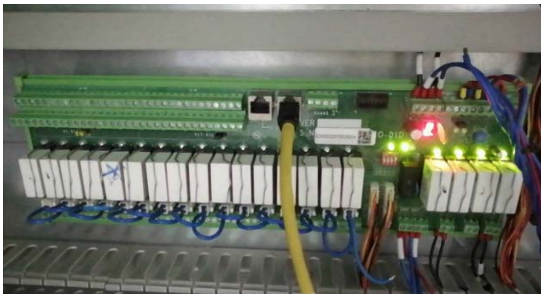
图 4-2 PRIO 板卡导轨安装图
